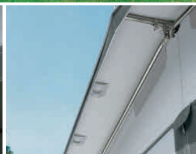
▲ Dwarssliggers onder de petluifel geven de luifel stabiliteit en zorgen voor een optimale pasvorm.
