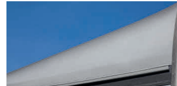
Buitenzijde dak metaallic gecoat.
